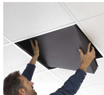
Después de retirar la losa inicial, inserción completa de la losa AirPanel en el techo
